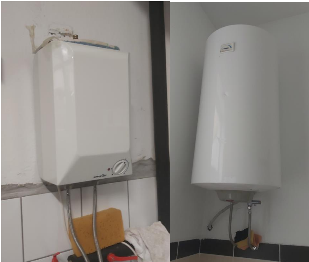
Slika 4.5: Električna bojlerja - Gorenje (levo) in Merloni (desno)
