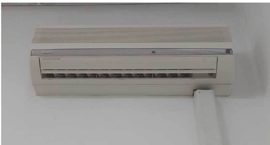
Slika 4.7 Starejša notranja enota klimatske naprave Gree
