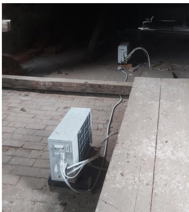
Slika 4.8 Zunanje enote klimatskih naprav na podstrešju
