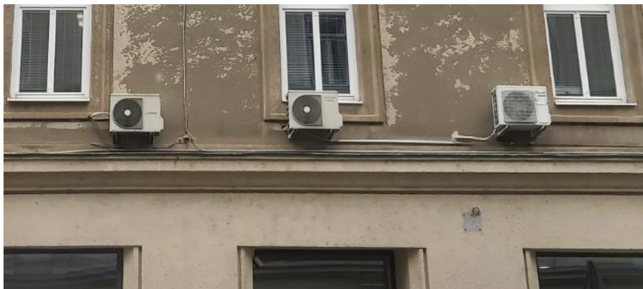
Slika 4.9 Zunanje enote klimatskih naprav na zunanjih mestih fasade
