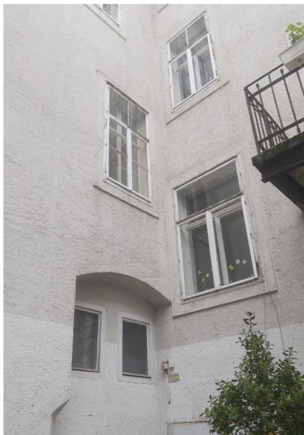
Slika 5.8: Škatlasta lesena okna na dvoriščni strani
