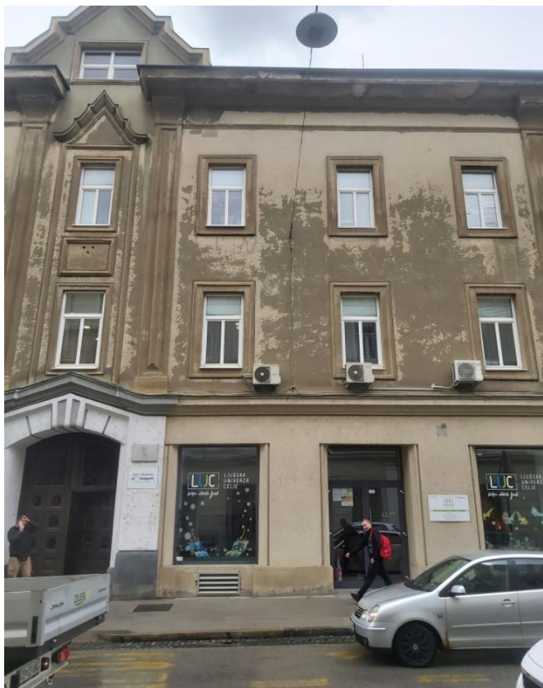
Slika 5.5: Obstoječa novejša dvoslojna PVC okna z notranjimi žaluzijami proti JZ (prvi in drugo nadstropje), ALU okna in vrata v pritličju v prostorih LUC
