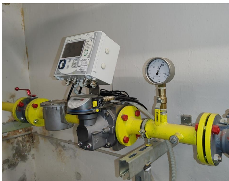
Slika 4.3 Rotacijski plinomer G-40 št. 4485984
