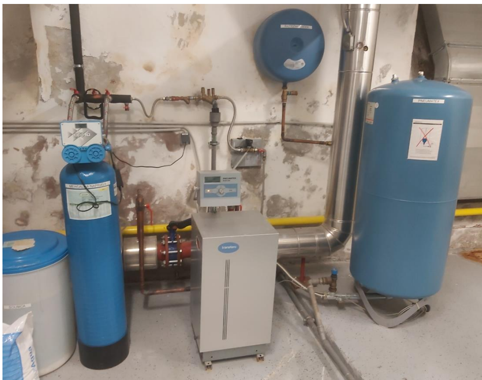
Slika 4.4 Mehčalna naprava (levo) in naprava za vzdrževanje tlaka PNEUMATEX (desno)
