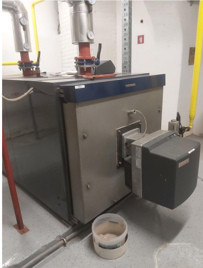
Slika 4.1: Kotlovnica s kotlom na zemeljski plin
