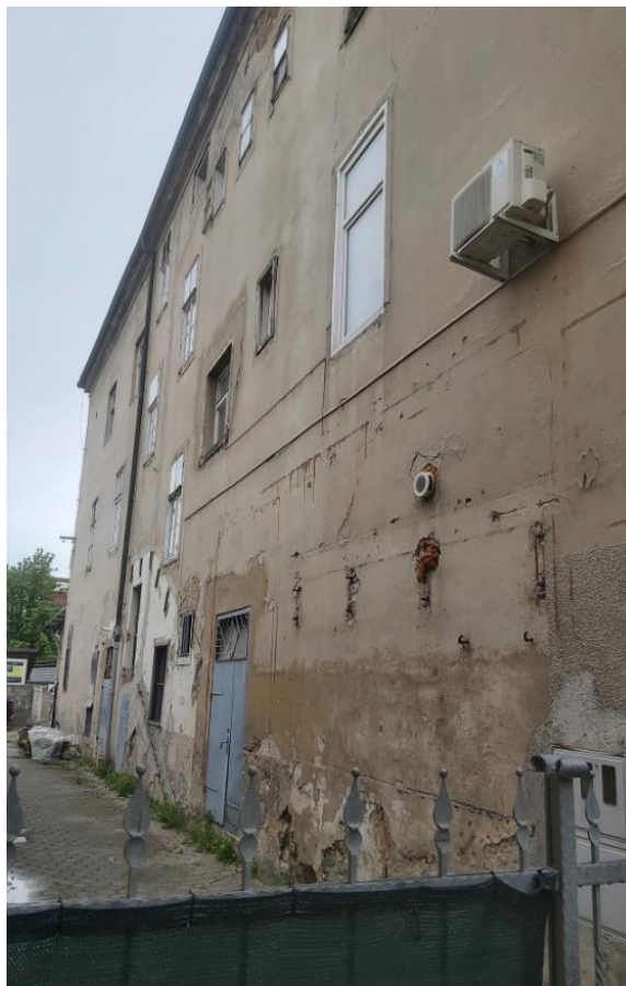
Slika 5.6: Starejša dvoslojna lesena okna proti SV in kovinska vrata
